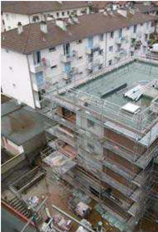
Echafaudages périphériques intégrant les protections en toiture
