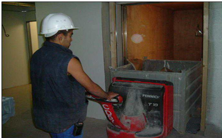
Evacuation des déchets
