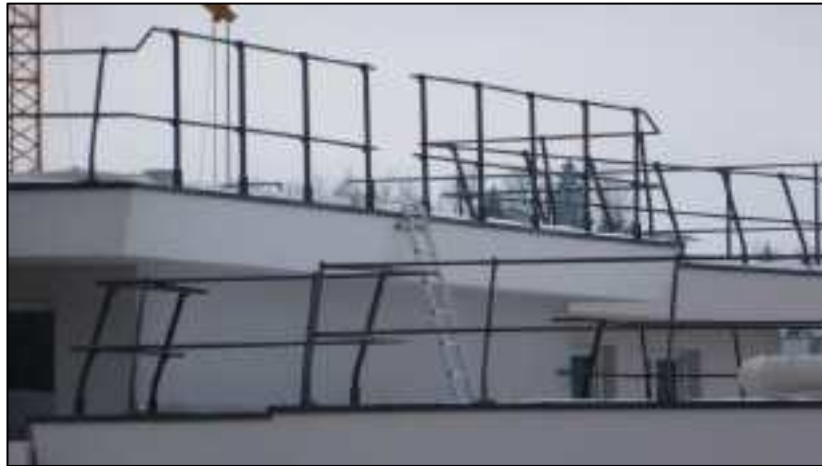
Sécurisation des interventions en rive des toitures planes
