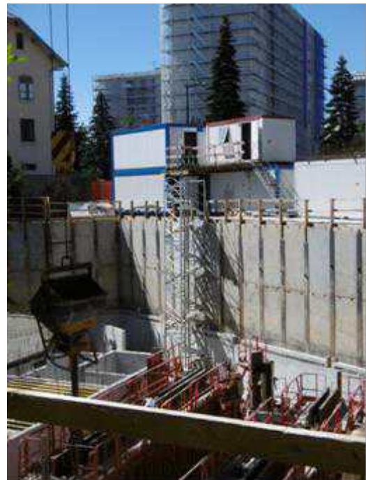
Accès en fond de fouille
