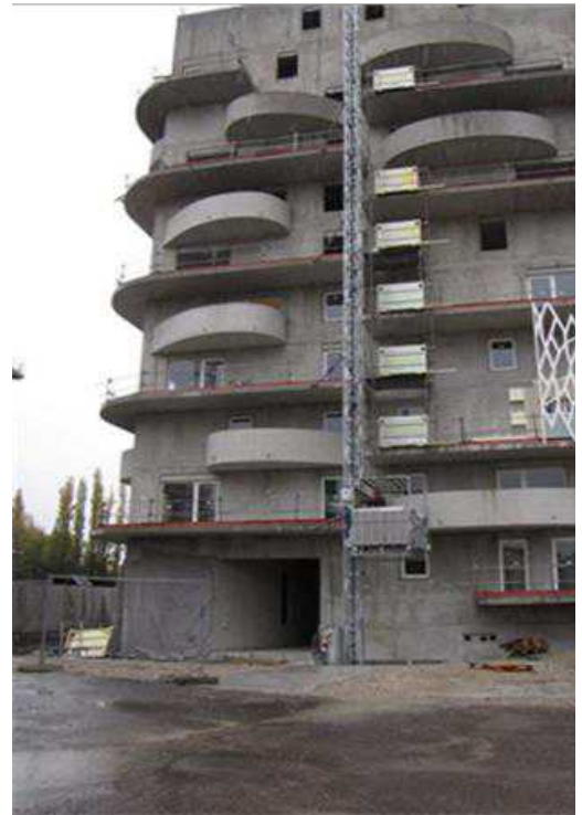
Lift adapté à la complexité du bâtiment
