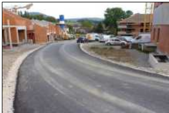
Création d'accès chantier
