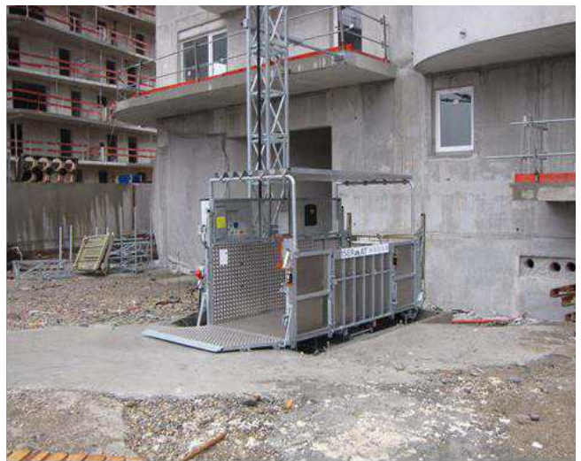
Lift approvisionnement à plat (bétonné)
