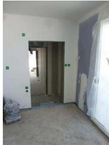
Mur « fusible » de communication entre bâtiment
